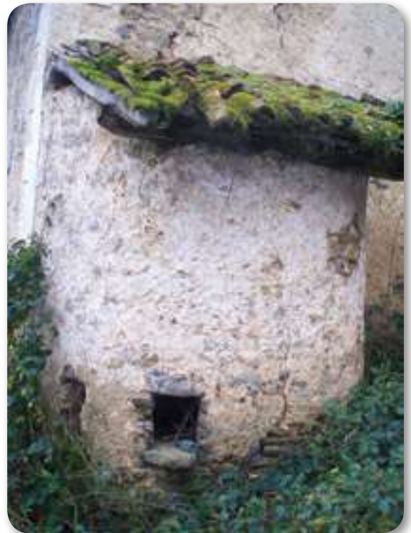
Ogia egiteko labea. Garai batean etxe gehienek beren ogia egiten zuten eta horrenbestez etxeari itsatsita labe asko zeuden, orain gehienak desagertu badira ere. Bi forma izaten zituzten: borobilak eta laukiak. Honako hau borobila da eta Bordan bordan dago. · Egilea: Igone Goikoetxea
